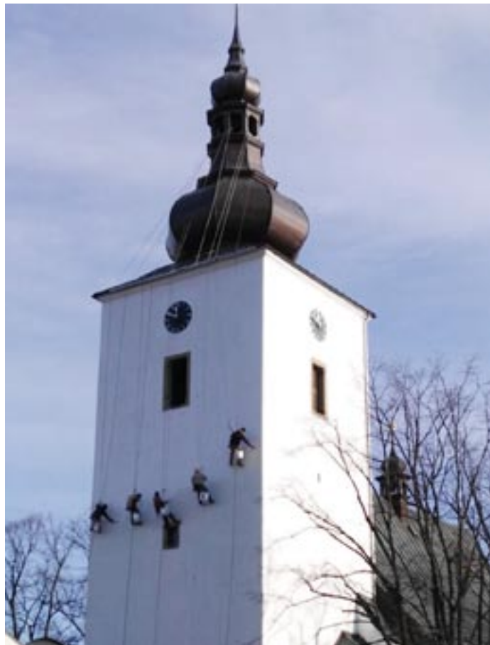
Oprava omítky na Horním kostele
