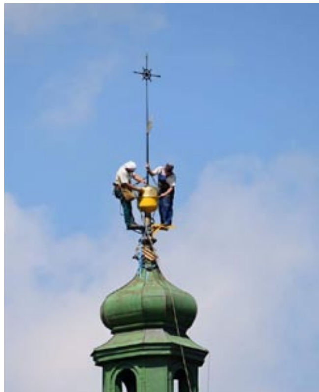
Oprava věže kostela sv. Martina
